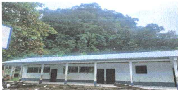
Foto 1: vista de la COPB Anexo A EORM finalizado sin pintar las paredes
