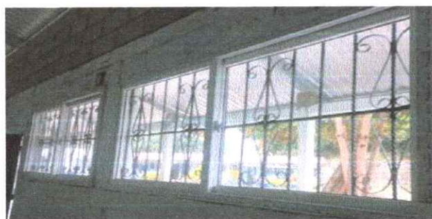
Foto 4: colocacion de ventanas PVC y balcones unicamente fueron pintadas
