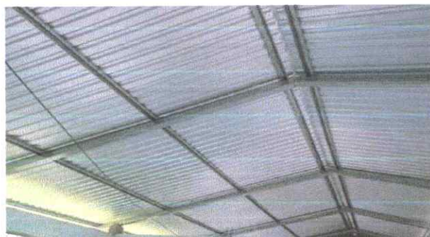
Foto 2: vista de la estructura metalica y techo finalizado
