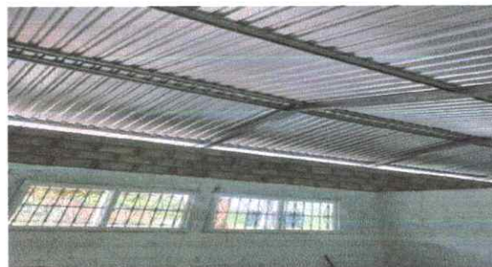
Foto 6: colocacion de 4 hila}das de bolck solera finalizado
