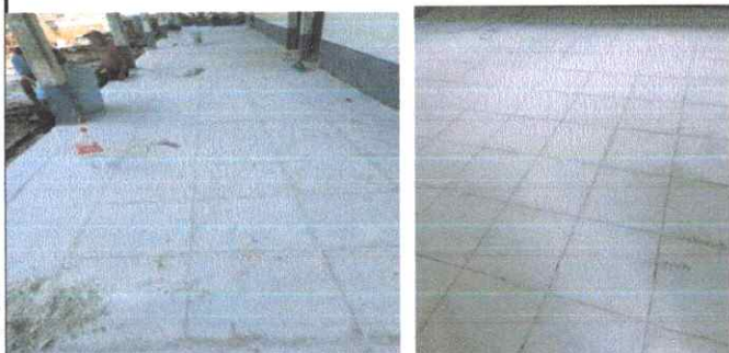
Foto 5: colocacion de piso ceramico de las tres aulas y corredor
